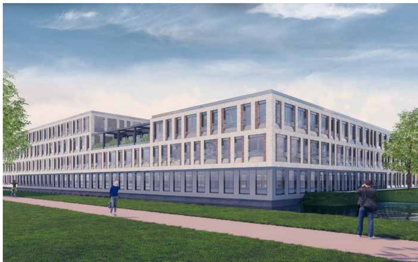
De prefab gevel met een eindafwerking in metselsteen.
